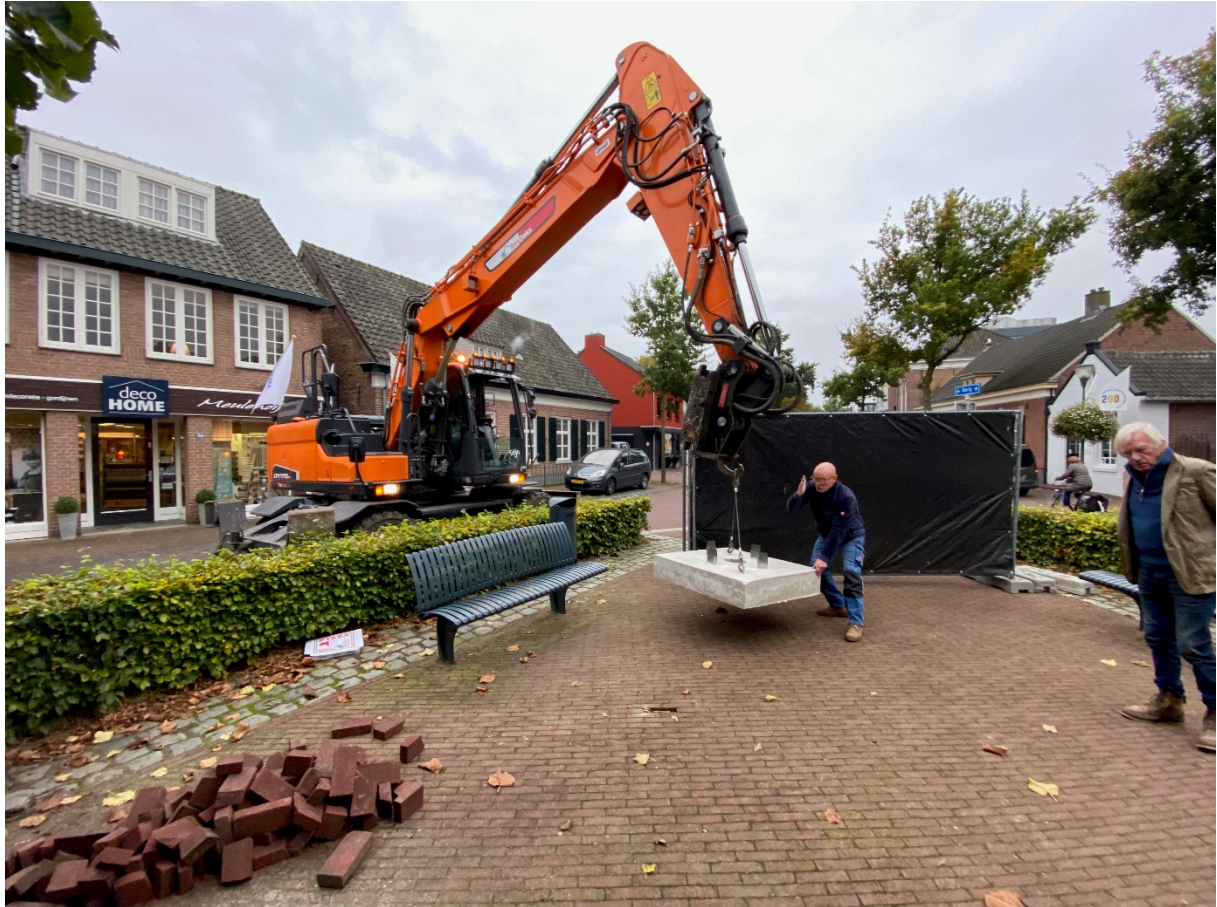
Foto 5: Het op zijn plaats brengen van de nieuwe betonnen fundering
