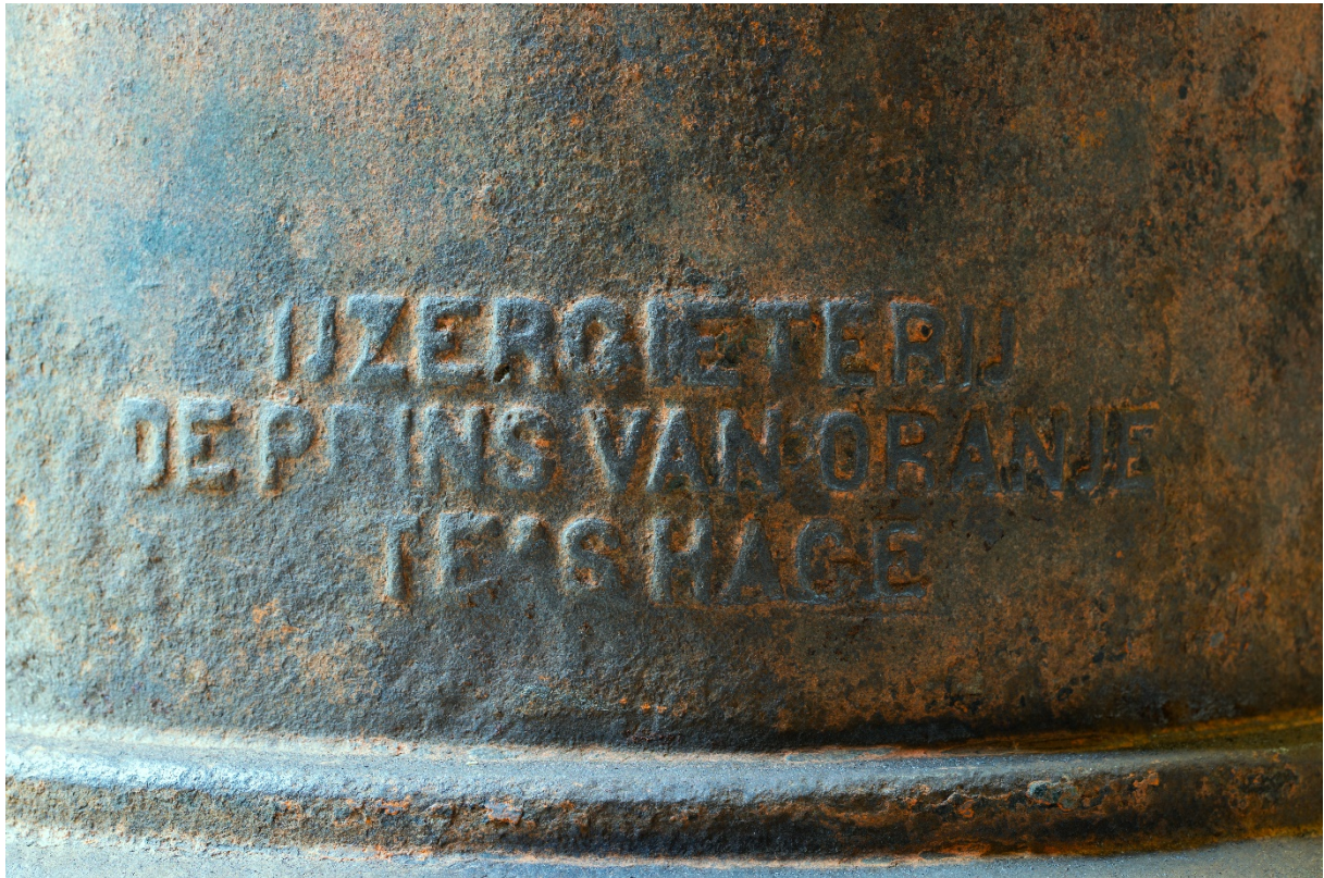
Foto 3: De meegegoten tekst van IJzergieterij de Prins van Oranje te 's Hage
