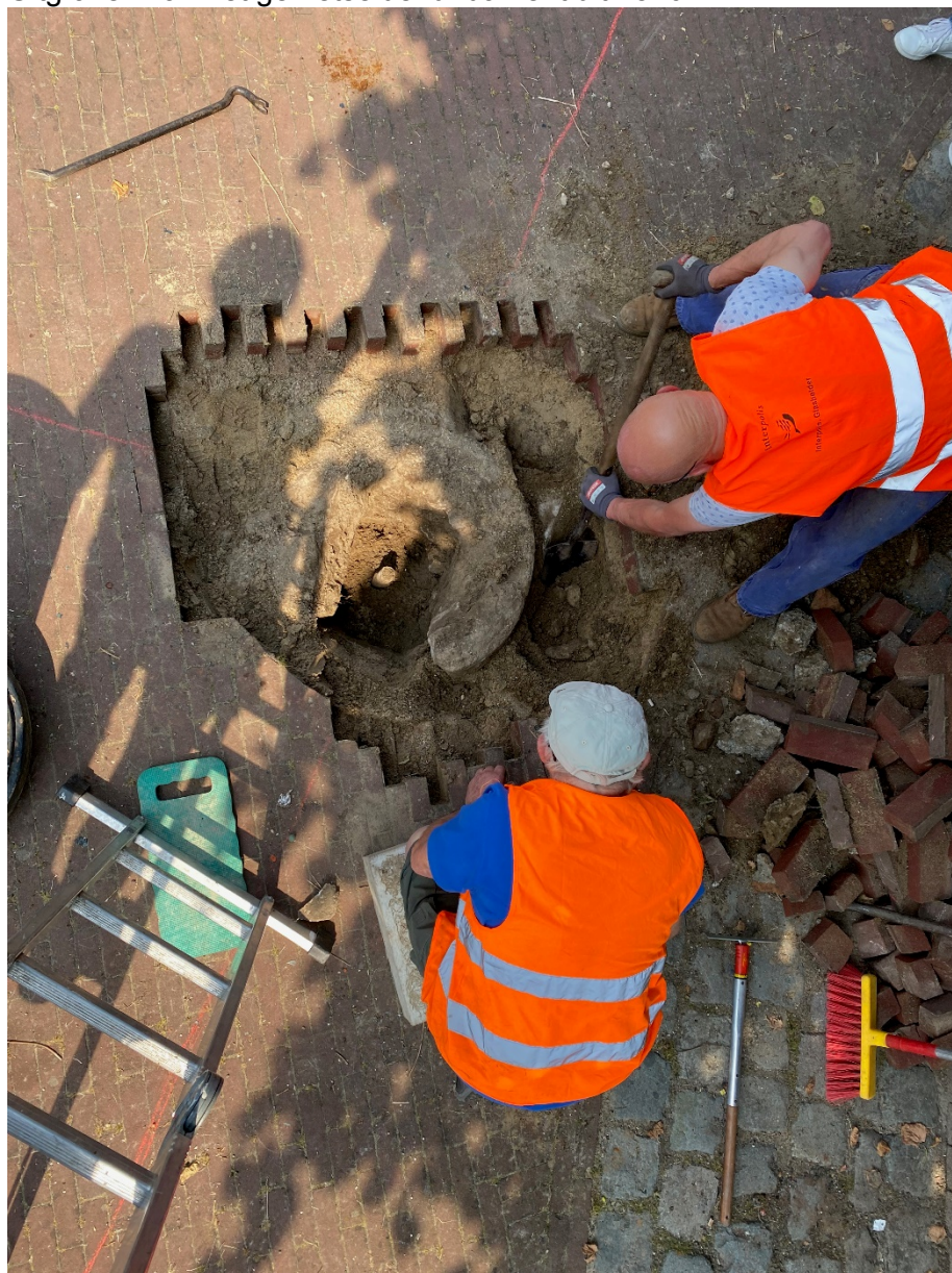
Foto 1: Uitgraven van het gemetselde fundament uit 1876
